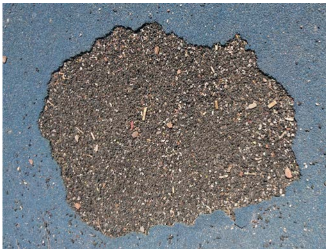
Figur 4. Exempel på slitage på fallskyddsytta, Vivelparken (foto: Mikael Olshammar, IVL)
